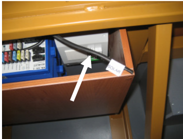
Précâblage sur le chargeur
