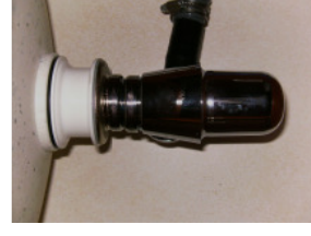
Röhrensiphon Waschbecken bei Mineralwerkstoff
