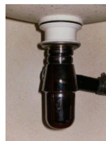
Röhrensiphon Waschbecken bei Mineralwerkstoff
