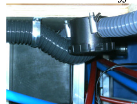
Röhrensiphon Waschbecken bei Mineralwerkstoff
