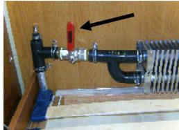
Die Konvektoren im Heckbettbereich und im Alkoven (grundrissabhängig) sind durch einen sogenannten Bypass mit dem Heizkreislauf verbunden und können deshalb separat über ein Ventil reguliert werden, das am Konvektor mit angebracht ist.
