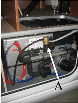
Die Heizung besitzt einen eingebauten Warmwasserbereiter mit einem Fassungsvermögen von etwa 8,5 Litern Frischwasser.
