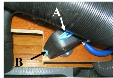
Löst das Ventil bei Frostgefahr automatisch aus, springt der Knopf „B“ heraus.
